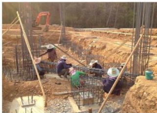
ลงเหล็กเสา, เหล็กคาน TEB - 4
