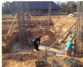
ลงเหล็กเสา, เหล็กคาน TEB - 4
