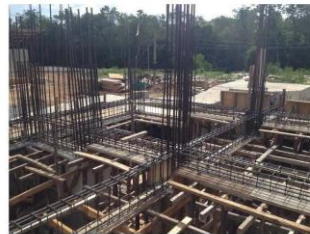
ลงเหล็กคานและเหล็กพื้น ชั้น +1.70
