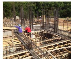
ลงเหล็กคานและเหล็กพื้น ชั้น +1.70
