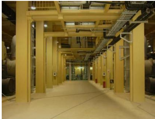
โครงสร้างเหล็กสำหรับระบบน้ำหล่อเย็น (Chilled Water System)
