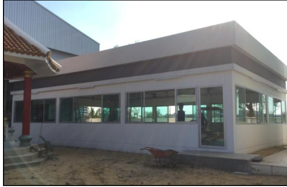
ภาพถ่ายความคืบหน้าการก่อสร้างศูนย์ปฏิบัติการฝึกอบรม (Training Workshop Practice)
