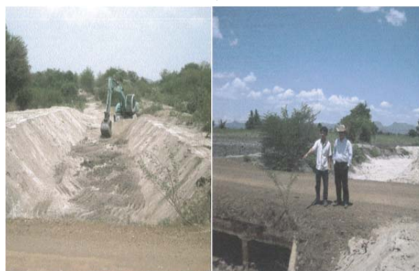
โครงการขุดลอกลำห้วยในชุมชนของโครงการ SSE1-PV01
