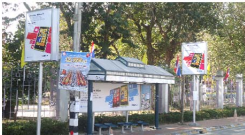
เชียงใหม่ - Bus Shelter
