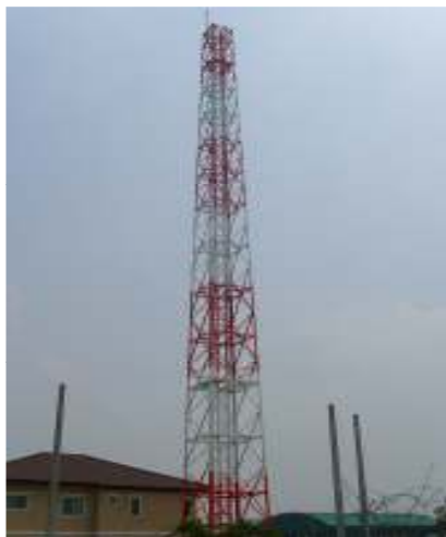
เสาโทรคมนาคมแบบ Self Supporting Tower
