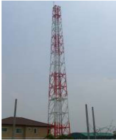
เสาสื่อคมนาคมแบบ Self Supporting Tower
