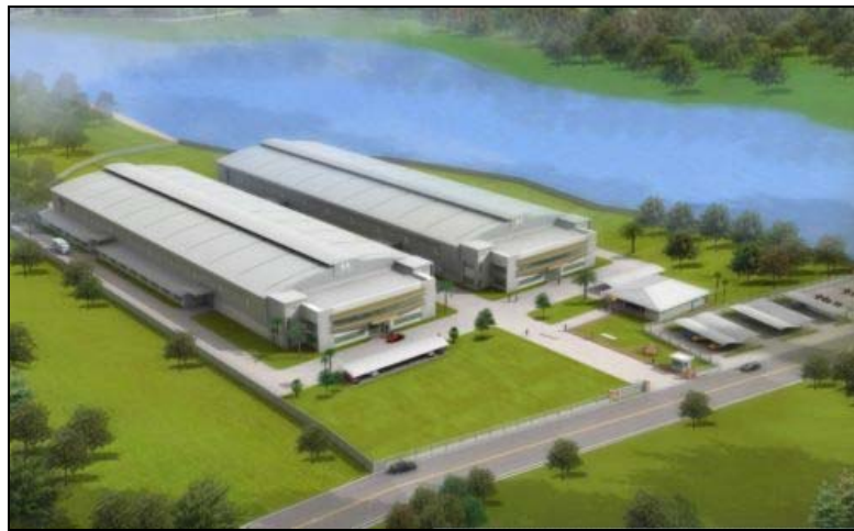
อาคารโรงงานที่จะดำเนินการก่อสร้าง
