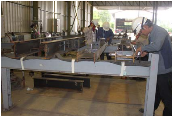
ชิ้นงานโครงสร้างเหล็กขณะประกอบที่โรงงานของบริษัทฯ
