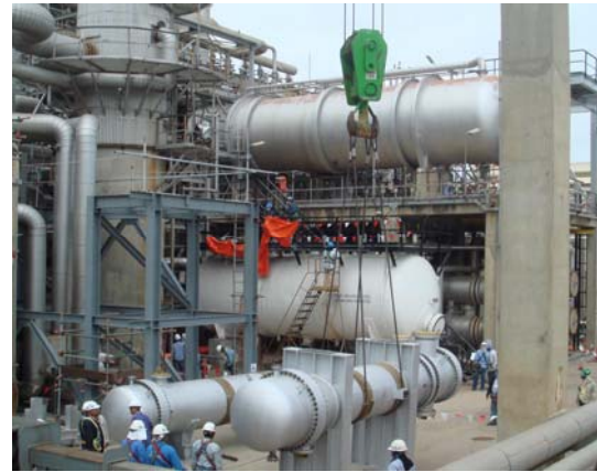
อุปกรณ์ขณะติดตั้งที่พื้นที่ก่อสร้าง
