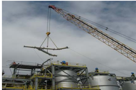
ชิ้นงานระบบท่อขณะติดตั้ง
