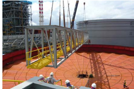
ชิ้นงานโครงสร้างเหล็กขณะติดตั้ง
