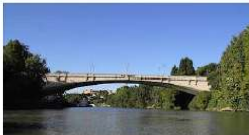
Figure 3: สะพานคอนกรีตเสริมเหล็ก Risorgimento ความยาวช่วง 328 ม/ดสร้างเมื่อปี1911 ในโรม
